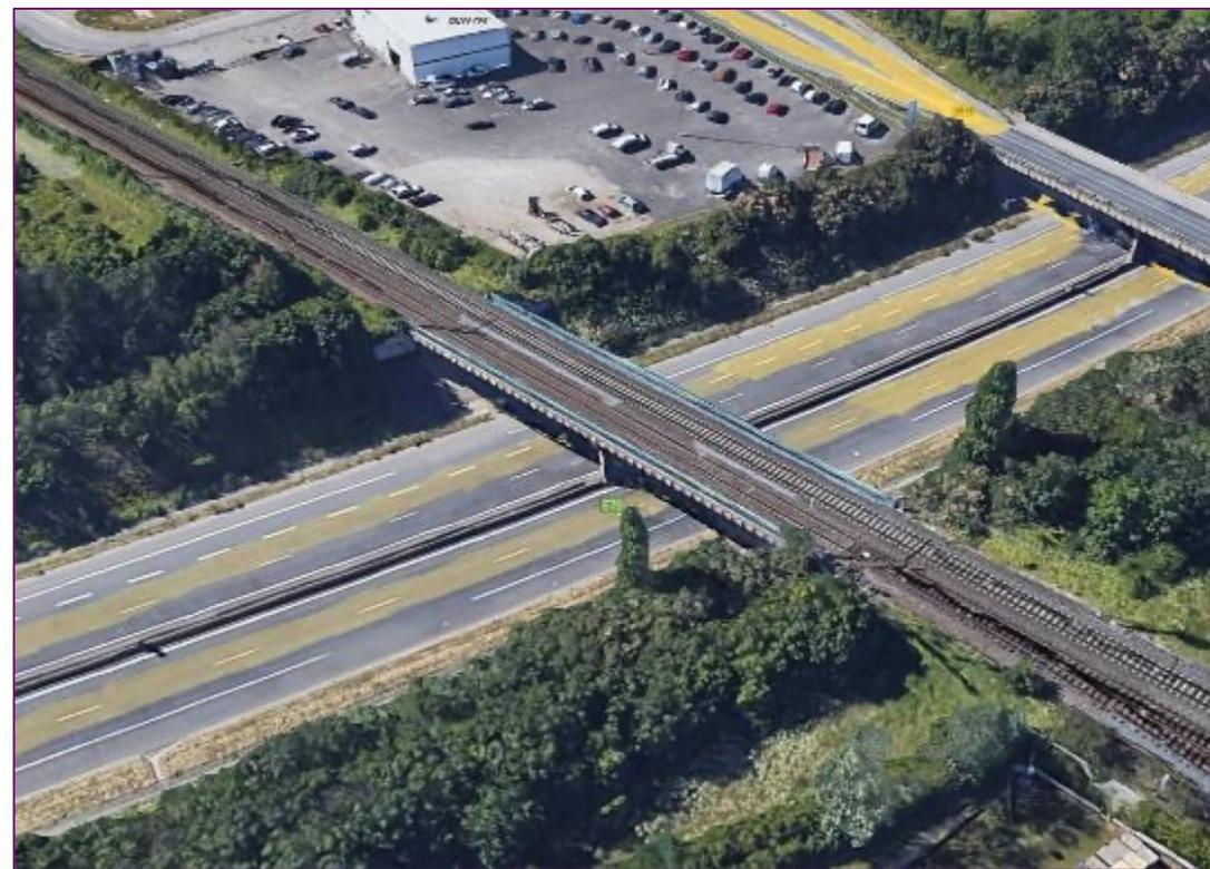
**Un franchissement souterrain sous l'A46 nécessite un approfondissement minimal de 15m vis-à-vis des voies existantes**
